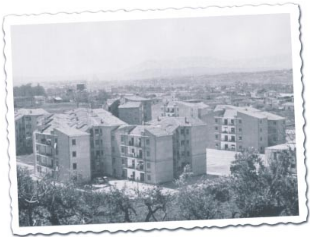
1962 - Chieti Scalo - Complesso INA-Casa
